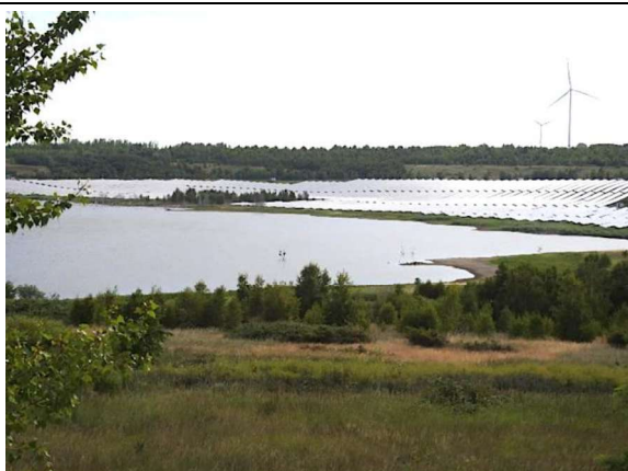
Südteil von Becken 6 mit Solarpark am östlichen Ufer
