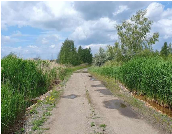
Weg auf dem Damm zwischen Becken 5 und 6 mit Schilfbestand beiderseits des Weges
