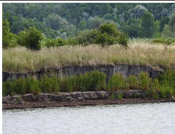
Abbruchkante am Nordrand des Beckens 6
