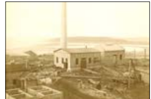
Bau der Pumpstation
