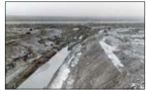
Bau des Mittelgrabens
