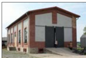
Maschinenhaus nach der Sanierung
