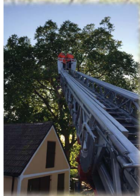
Mit großer Technik wurden Schäden beseitigt.
