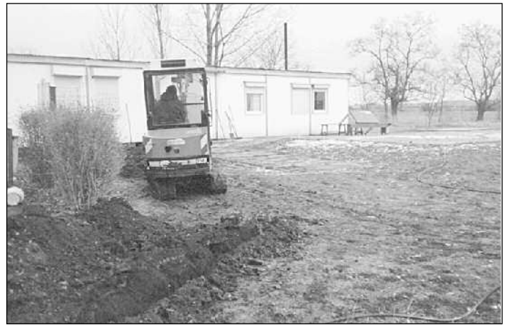
1995 wurden Raumzellen aufgestellt und Erdkabel verlegt.
